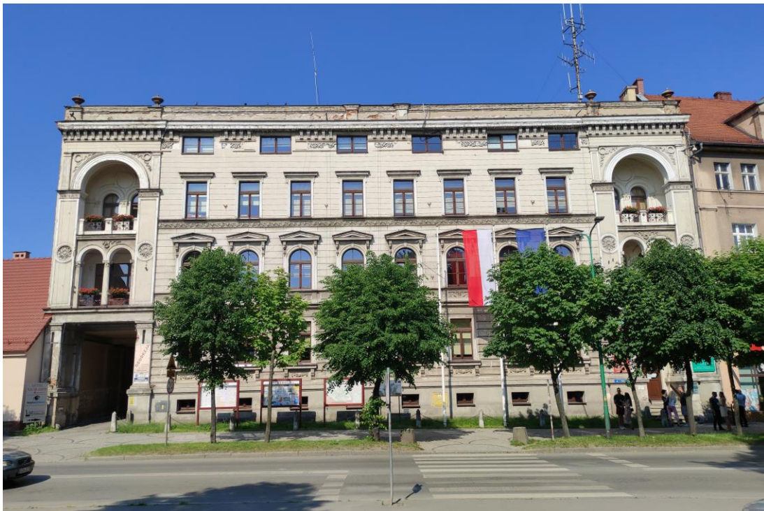
Widok budynku od wschodu.
