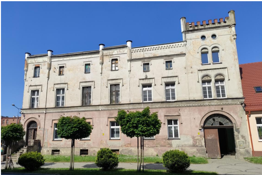
Widok budynku od wschodu.
