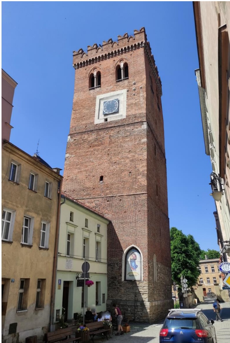
Widok budynku od północnego – wschodu.
