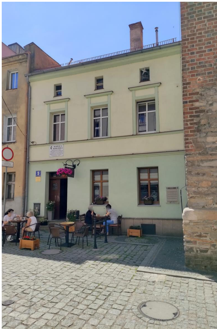
Widok budynku od północy.
