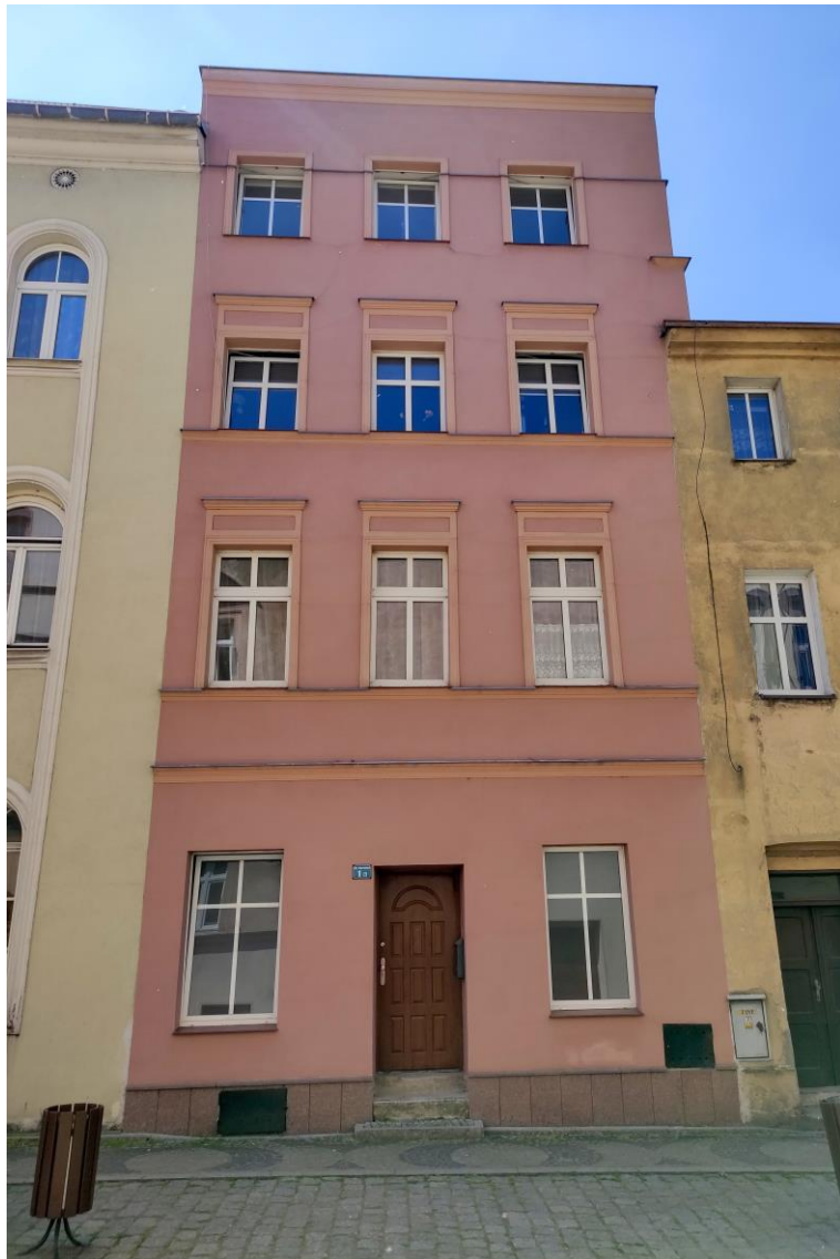
Widok budynku od północy.
