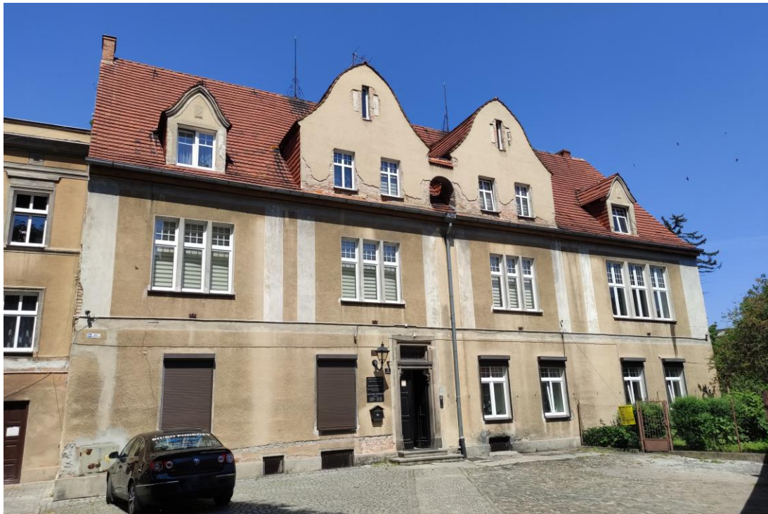
Widok budynku od południowego – wschodu.
