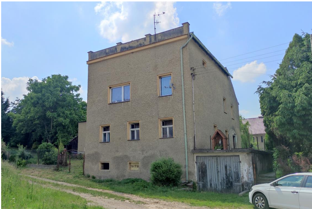
Widok budynku od wschodu.
