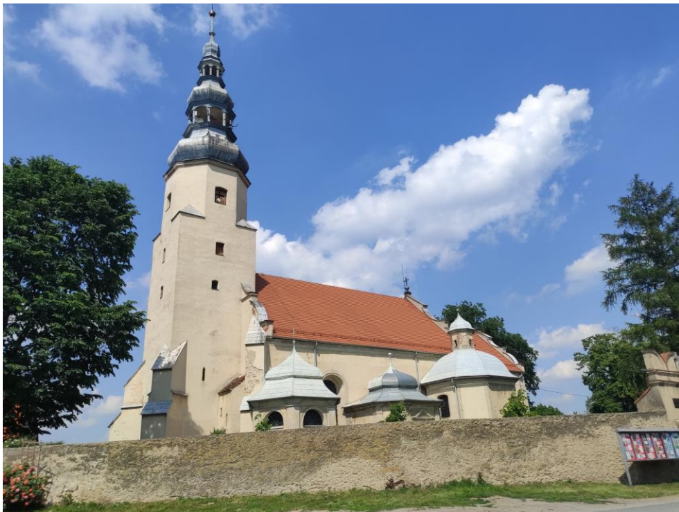
Widok budynku od południowego – zachodu.
