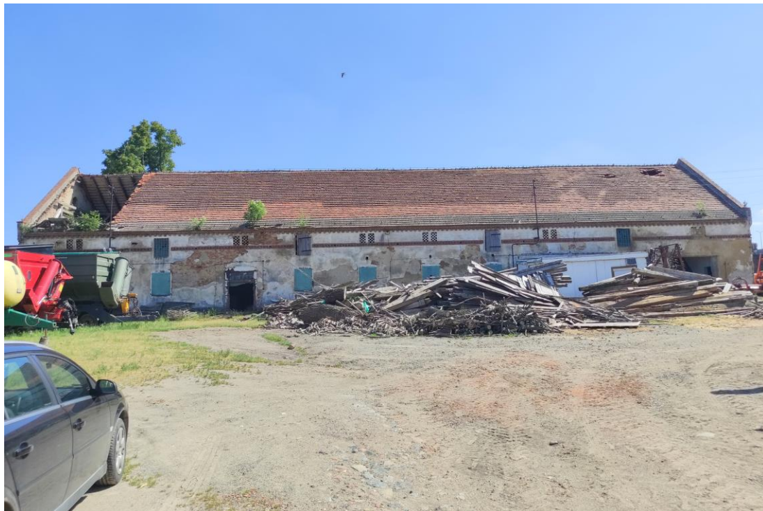
Widok budynku od północy.
