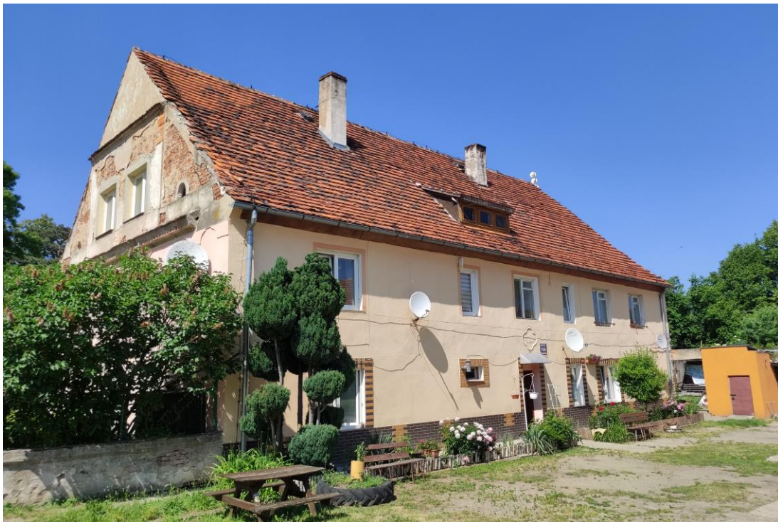
Widok budynku od południowego – zachodu.
