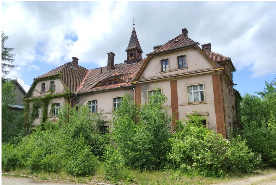
Widok budynku od północnego – wschodu.
