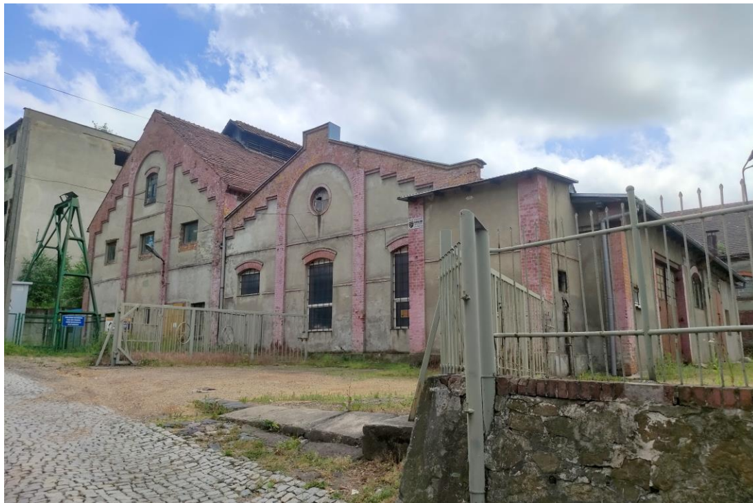
Widok budynku od północnego – zachodu.
