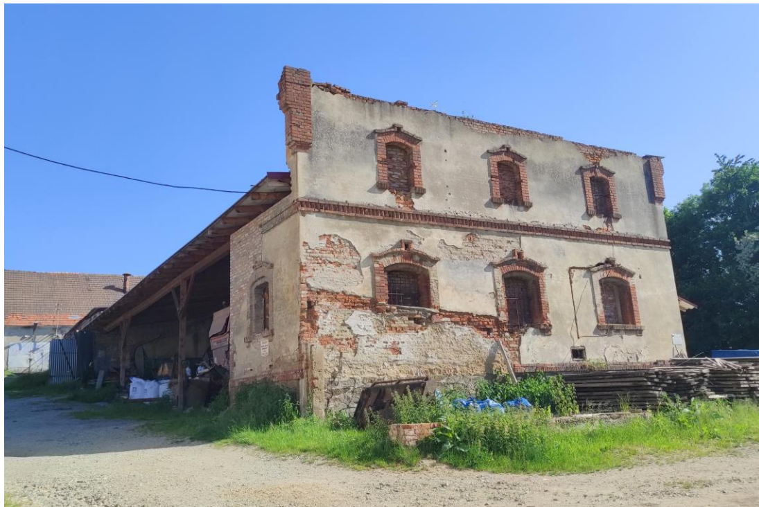
Widok budynku od północy.
