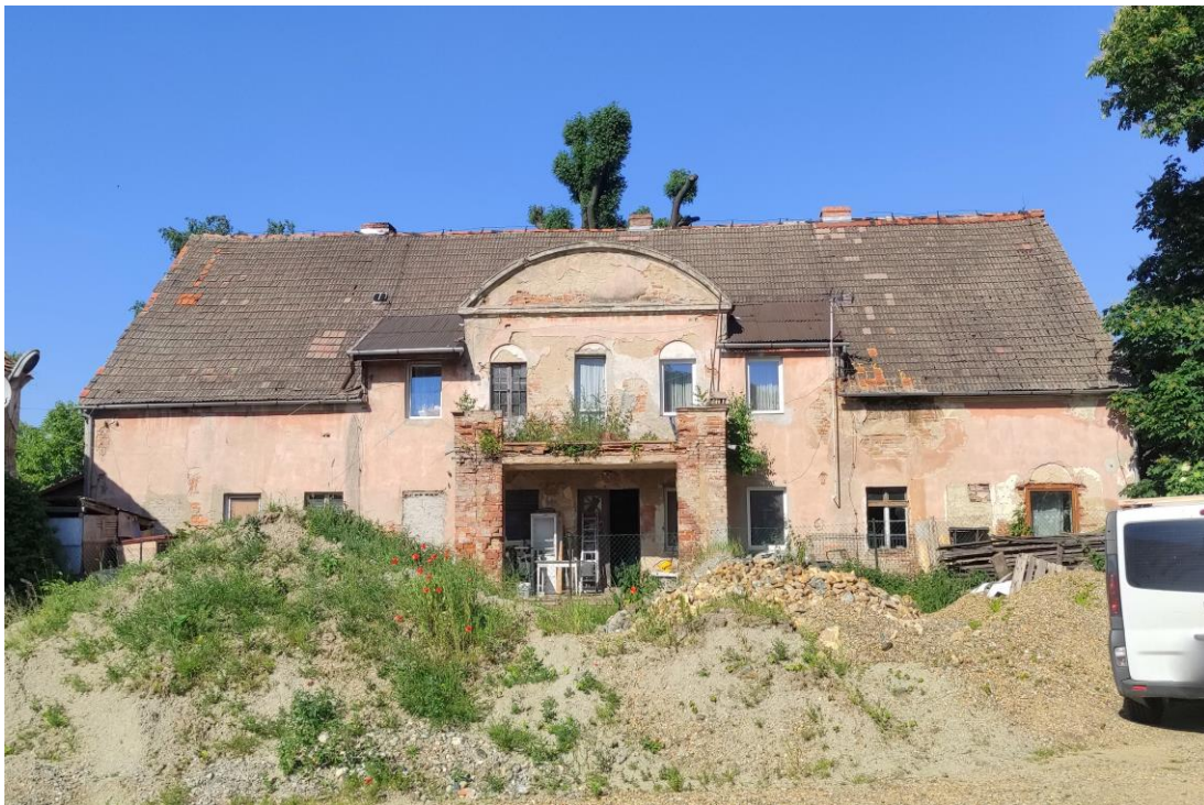
Widok budynku od południowego – zachodu.
