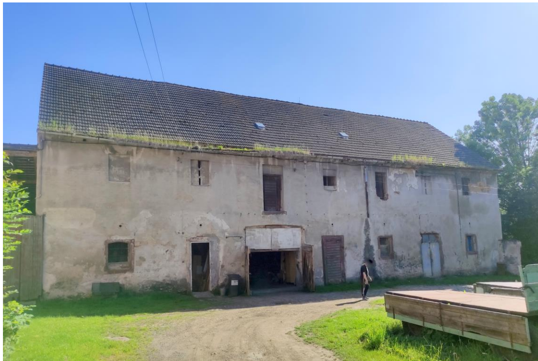
Widok budynku od północy.
