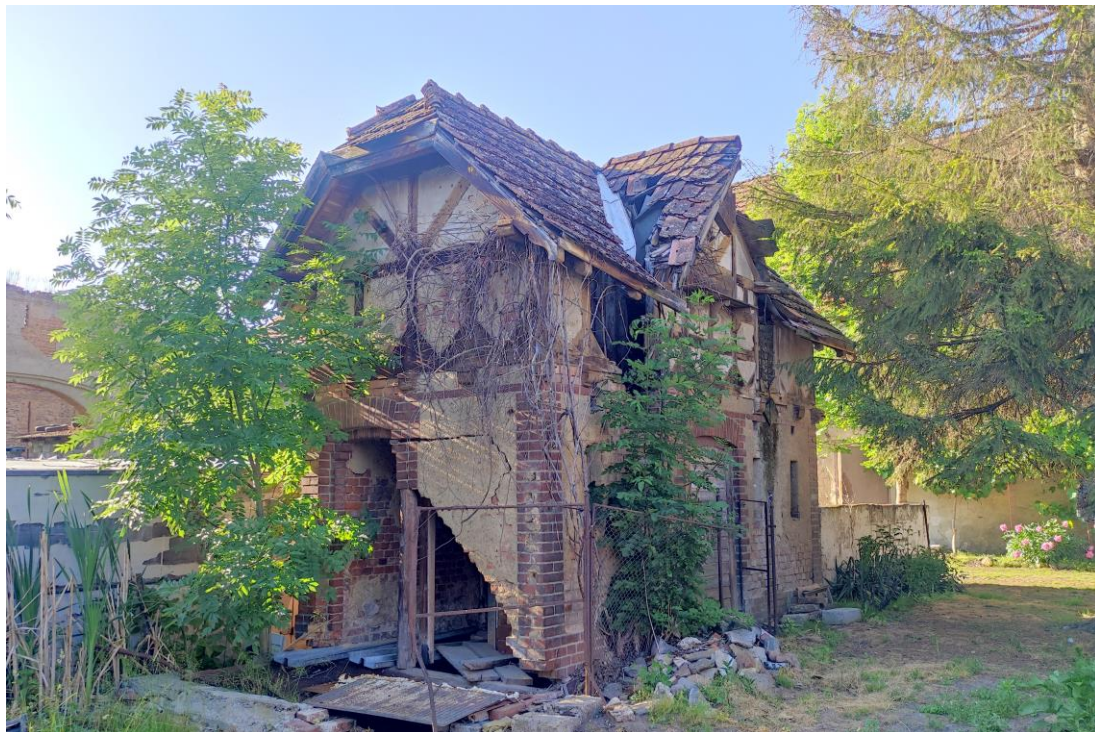
Widok budynku od południowego – wschodu.
