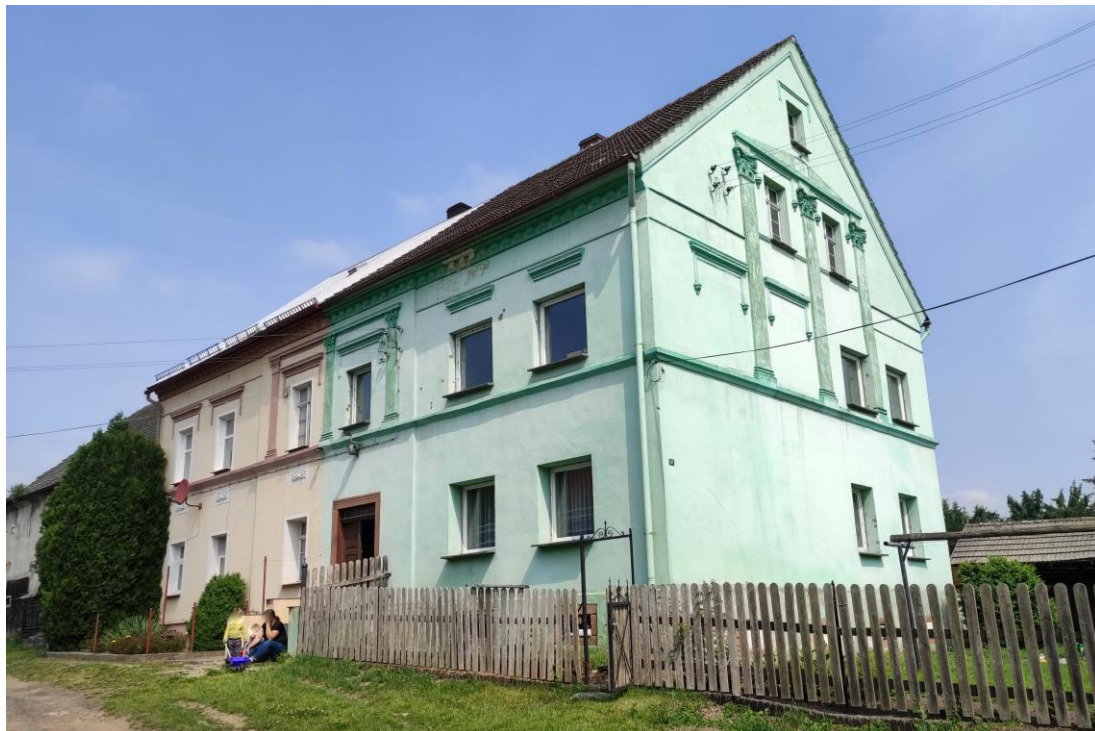
Widok budynku od południowego – wschodu.
