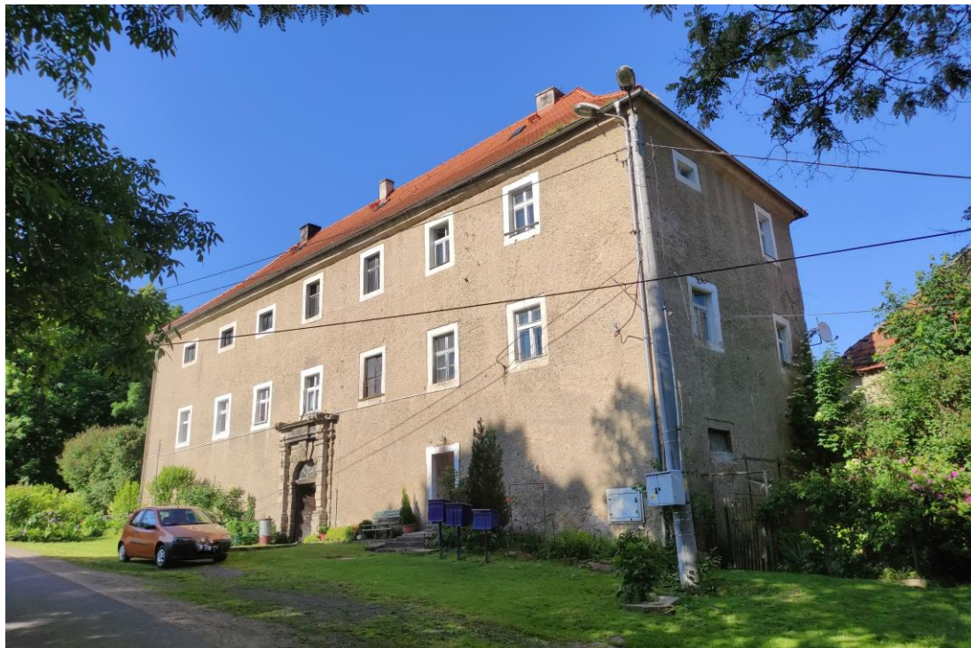
Widok budynku od południowego – zachodu.
