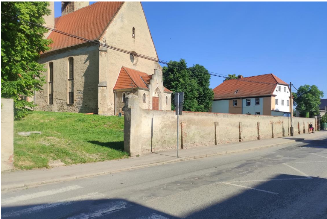
Widok budynku od północnego – zachodu.
