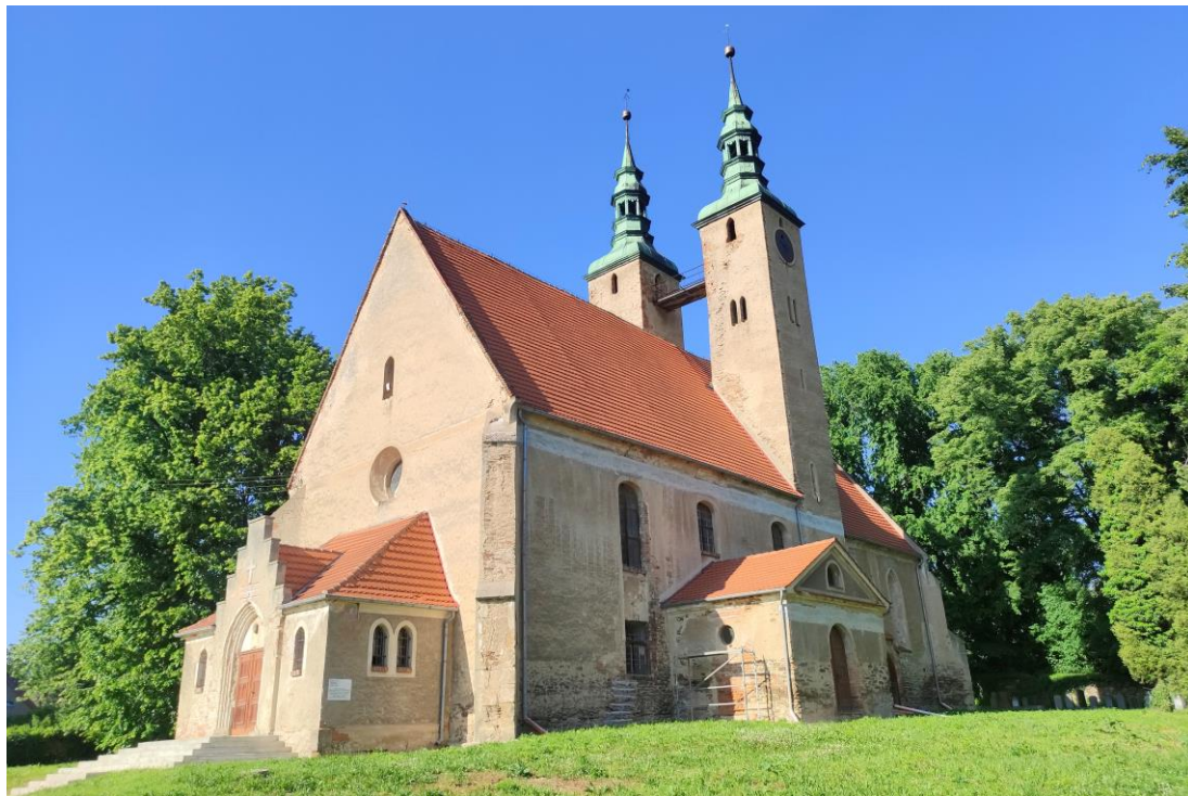
Widok budynku od południowego – zachodu.
