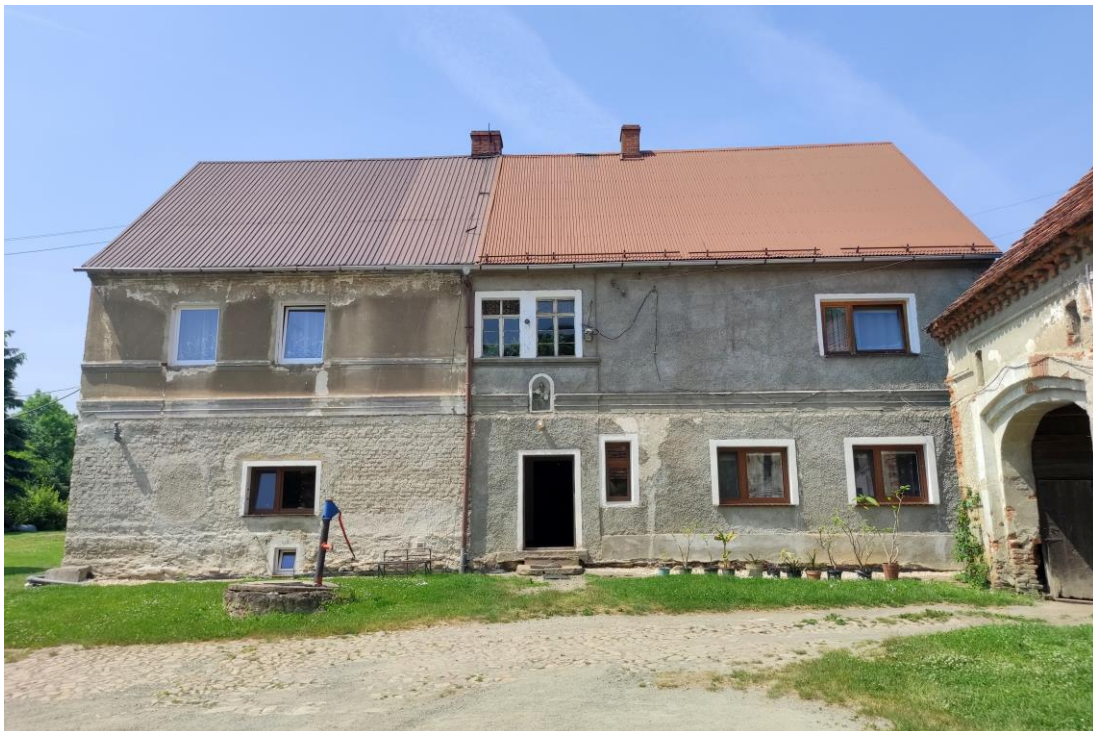
Widok budynku od północnego – wschodu.
