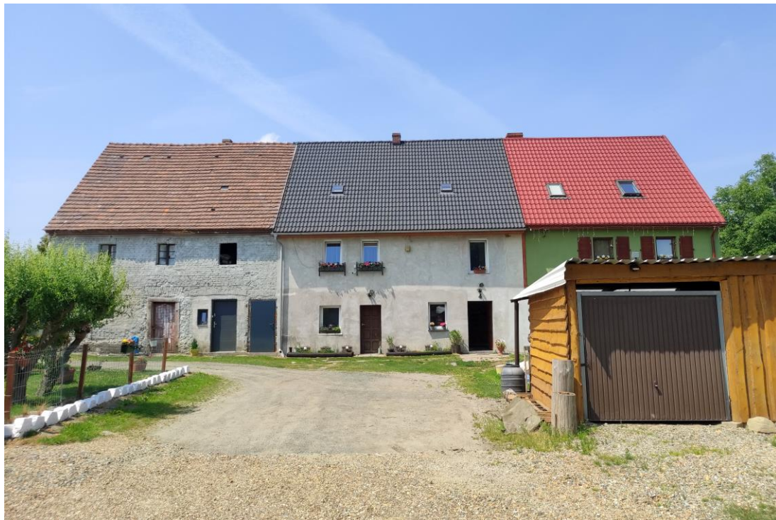
Widok budynku od wschodu.
