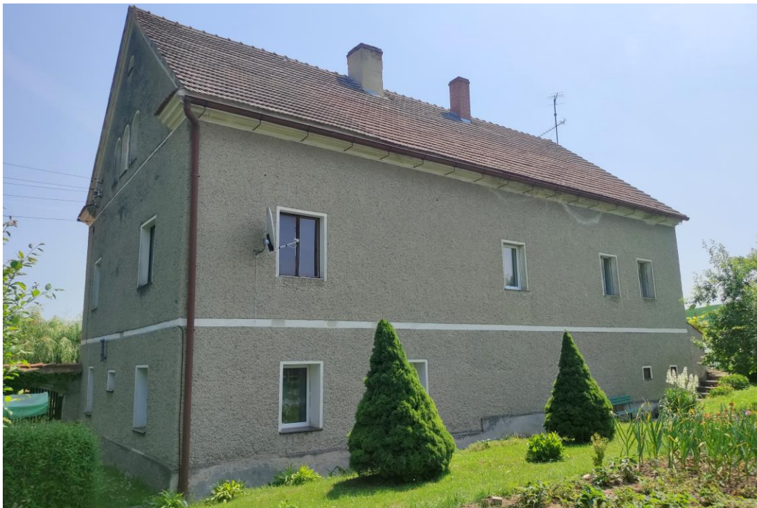
Widok budynku od północnego – zachodu.
