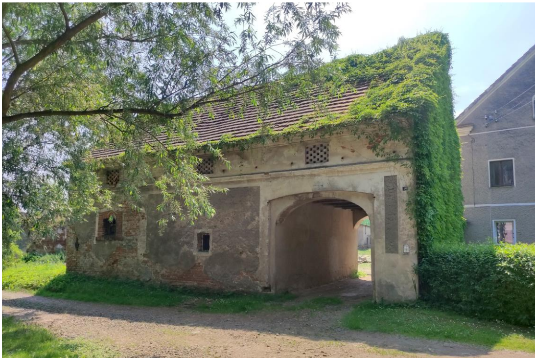
Widok budynku od północnego – zachodu.
