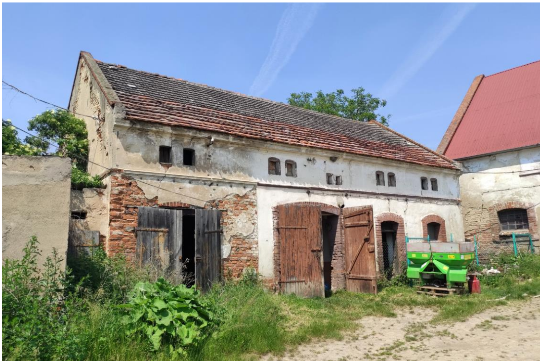
Widok budynku od południowego – wschodu.
