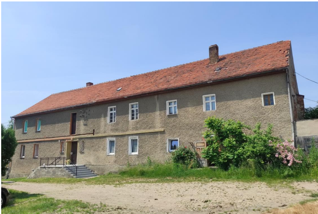
Widok budynku od północnego – wschodu.
