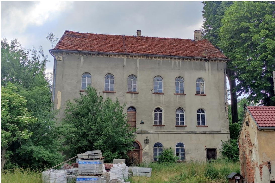
Widok budynku od wschodu.
