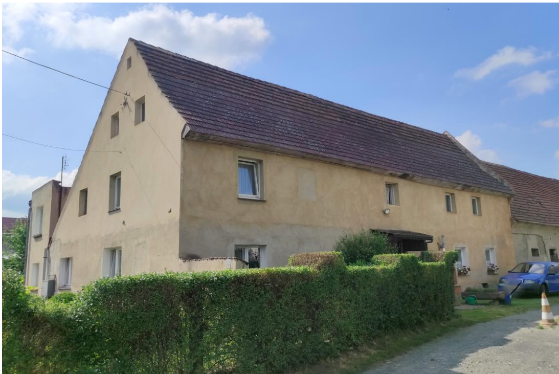
Widok budynku od południowego – wschodu.
