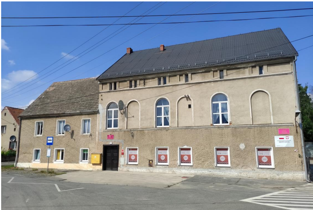
Widok budynku od południowego – zachodu.
