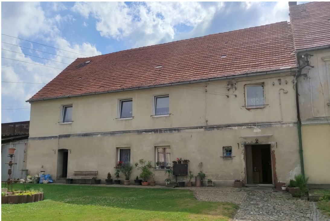
Widok budynku od północnego – wschodu.
