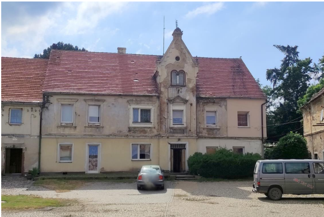
Widok budynku od północnego – wschodu.
