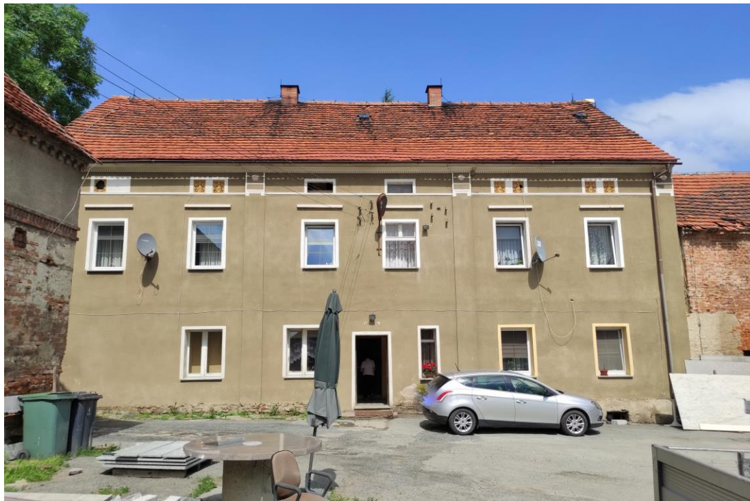
Widok budynku od południowego – zachodu.
