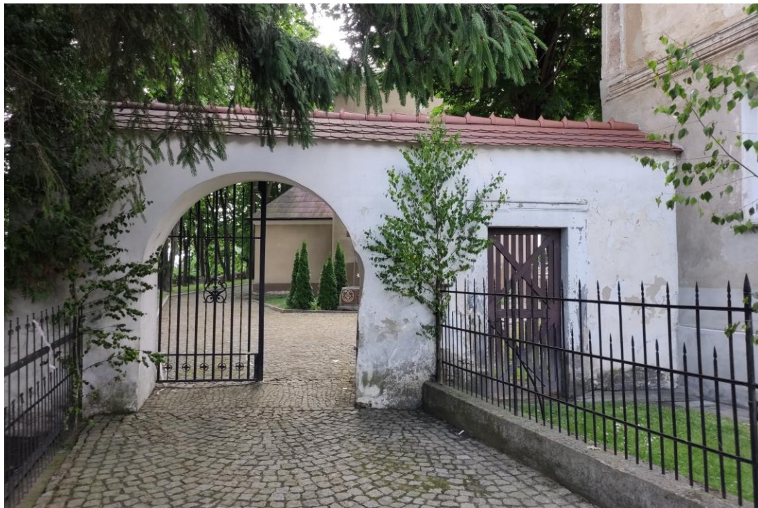
Widok budynku od północnego – wschodu.
