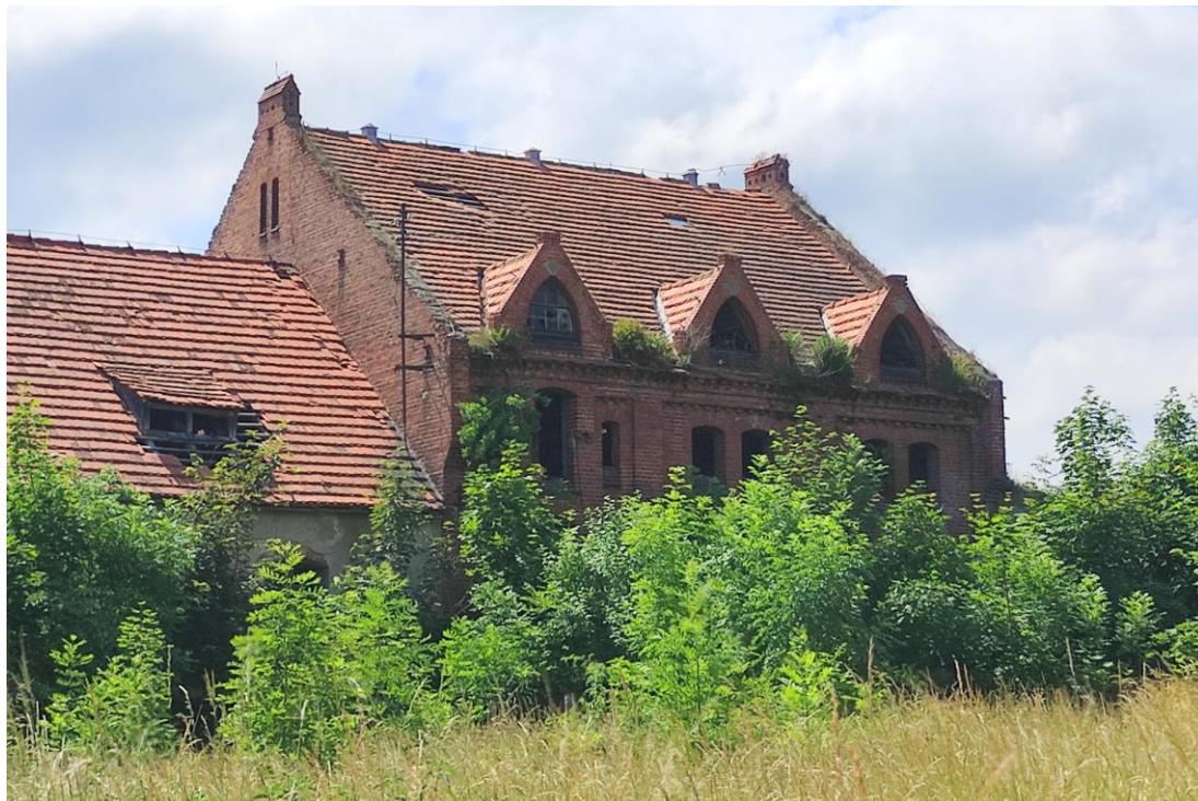
Widok budynku od wschodu.
