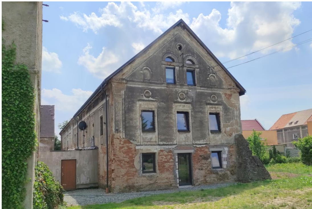
Widok budynku od północnego – zachodu.
