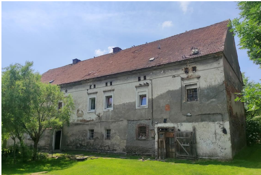
Widok budynku od wschodu.
