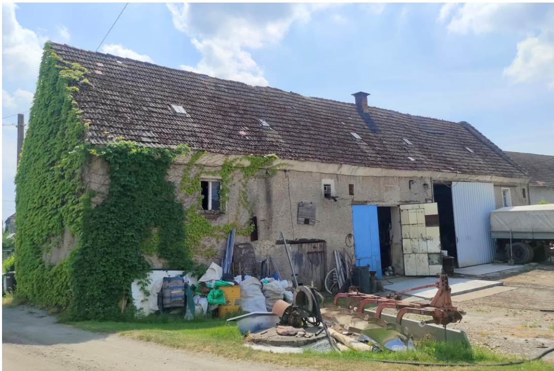
Widok budynku od północnego – wschodu.
