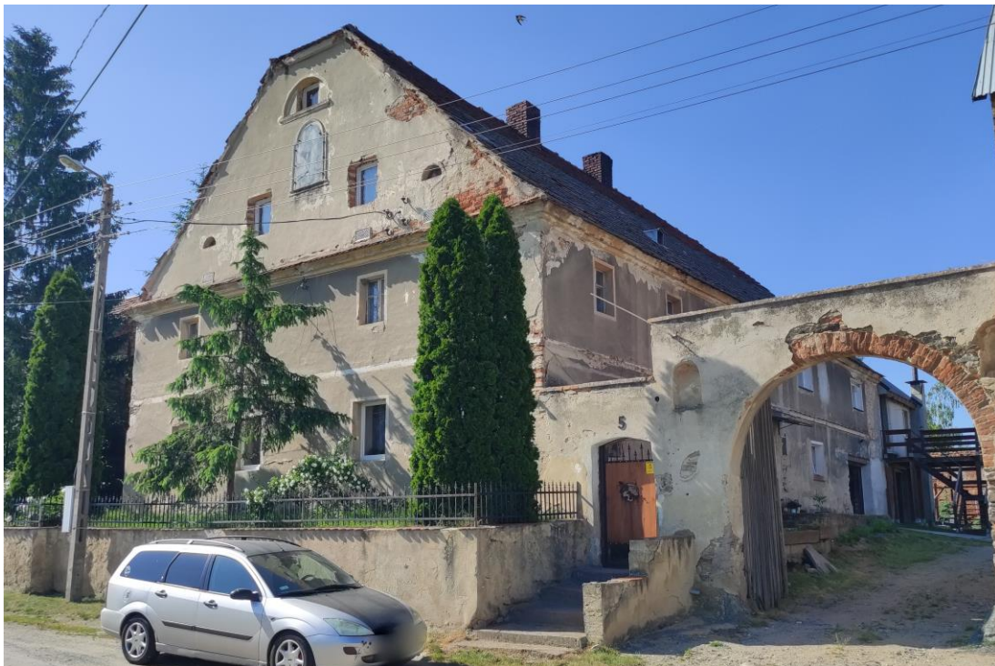
Widok budynku od południowego – wschodu.
