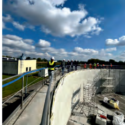
Modernizacja oczyszczalni ścieków przy ul. Rzecznej w Ząbkowicach Śląskich
