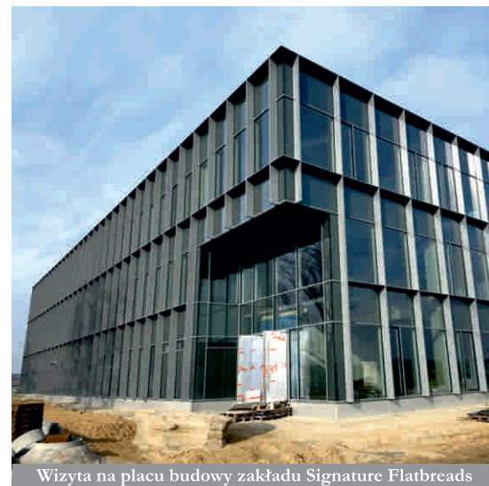
Wizyta na placu budowy zakładu Signature Flatbreads
