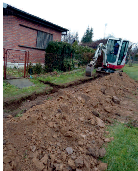
ROD “Wypoczynek” – I etap elektryfikacji ogrodu
