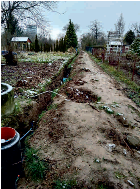
ROD “Hutnik” – modernizacja sieci wodociągowej
