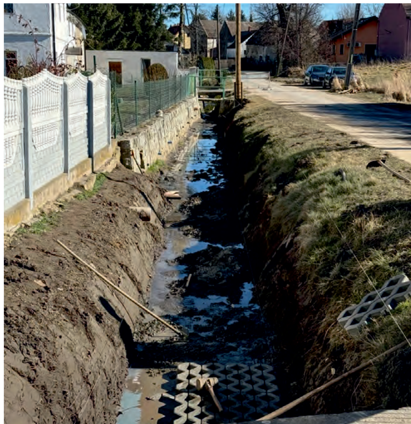
Czyszczenie, naprawa i umocnienie koryta potoku Braszówka po powodzi w miejscowościach Pawłowice i Braszowice
