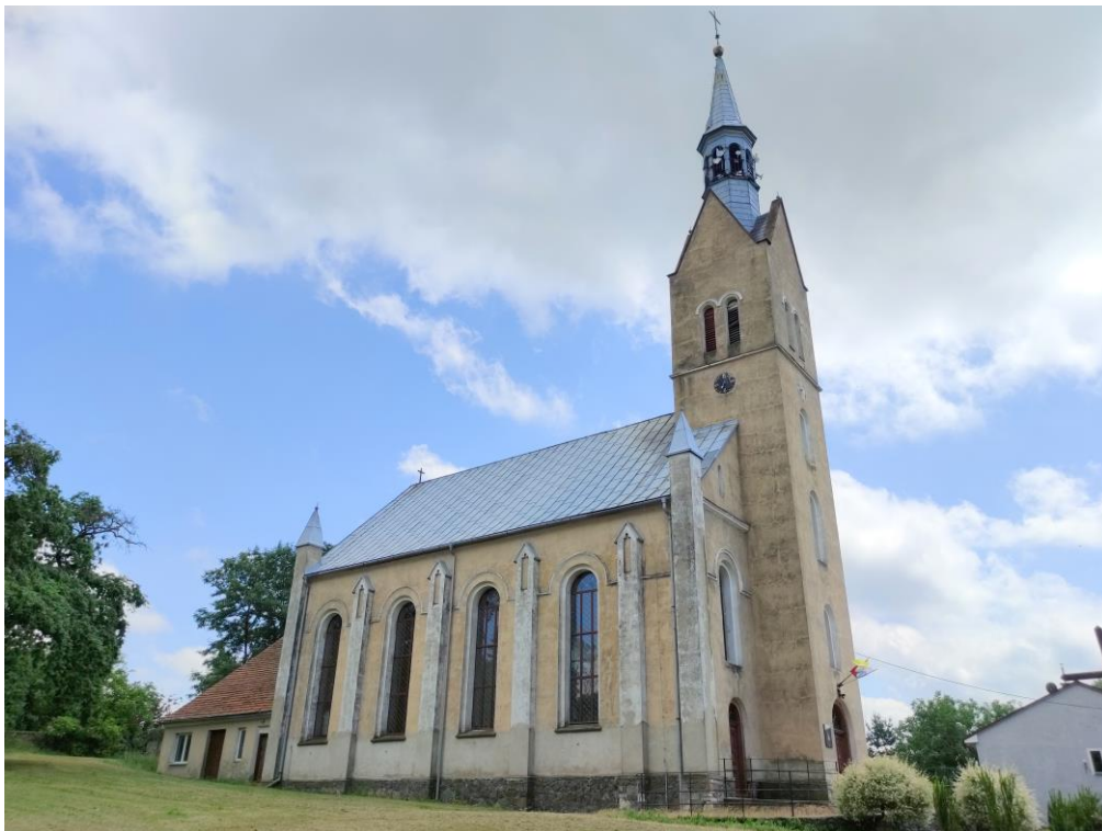
Widok od północnego - zachodu.
