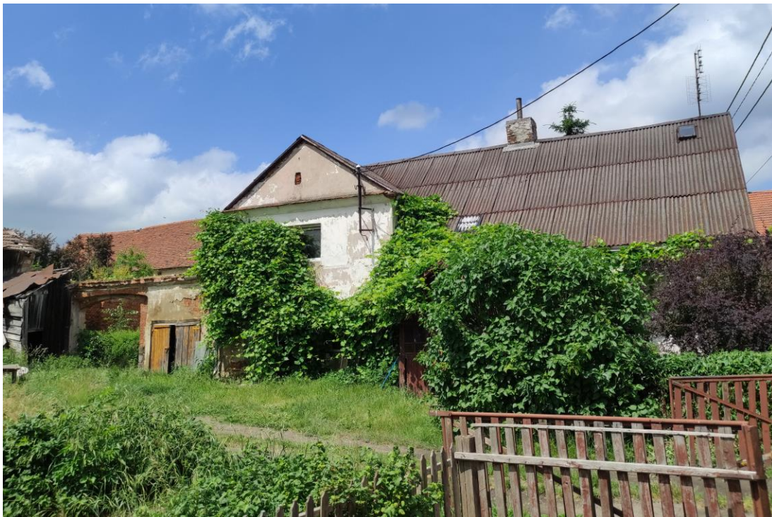
Widok budynku od południa.
