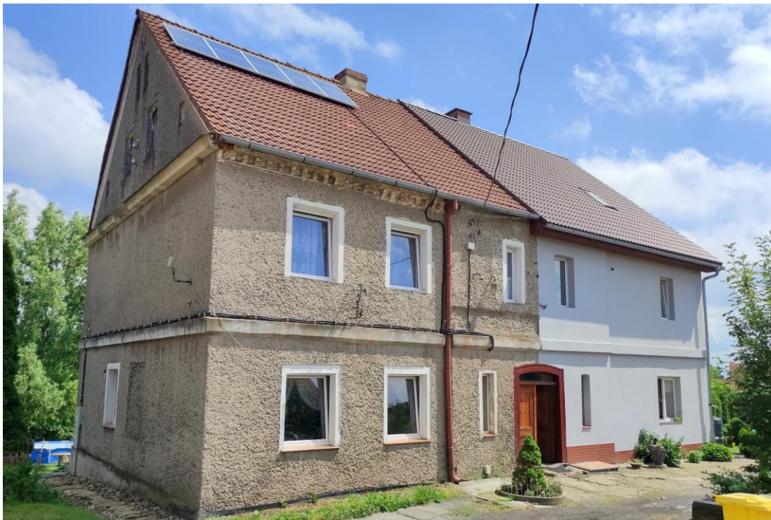
Widok budynku od północnego - zachodu.
