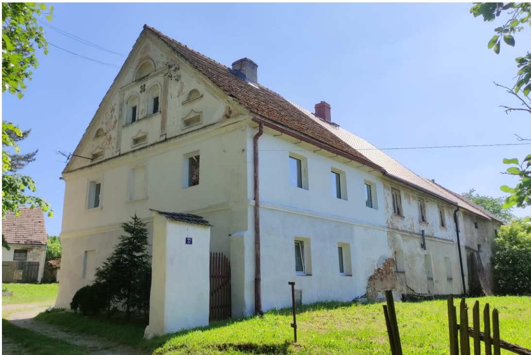
Widok budynku od północnego – wschodu.
