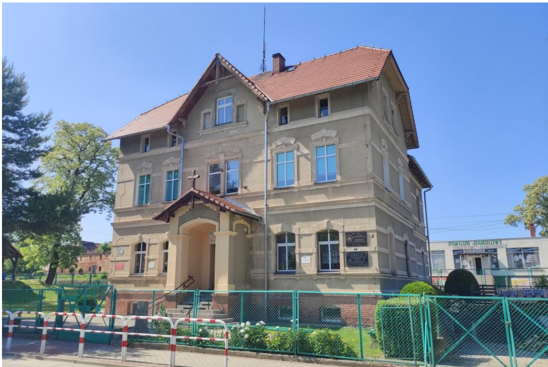
Widok budynku od południowego – wschodu.
