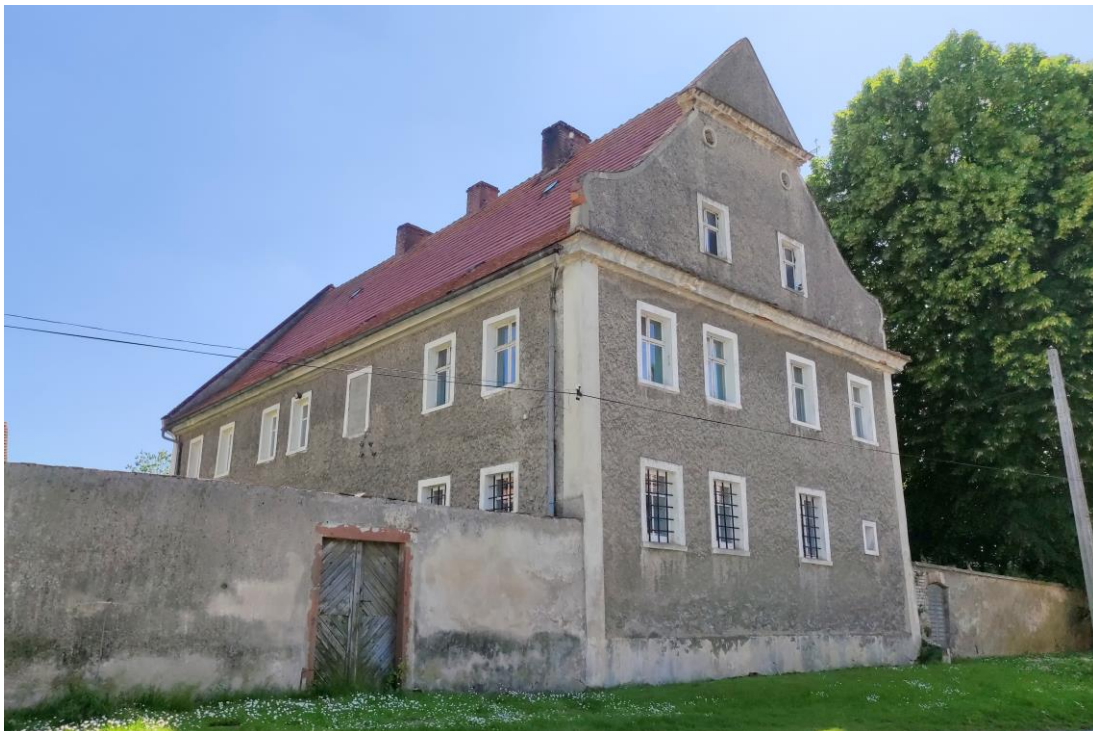
Widok budynku od północnego – wschodu.
