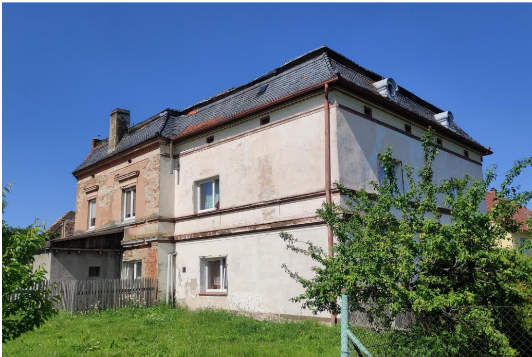
Widok budynku od południowego – zachodu.
