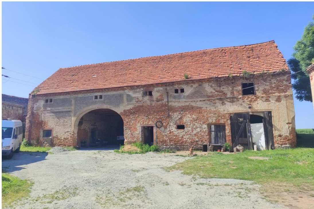
Widok budynku od południa.
