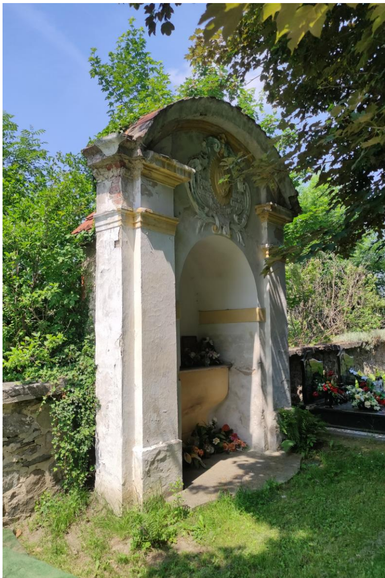
Widok od południowego – wschodu.
